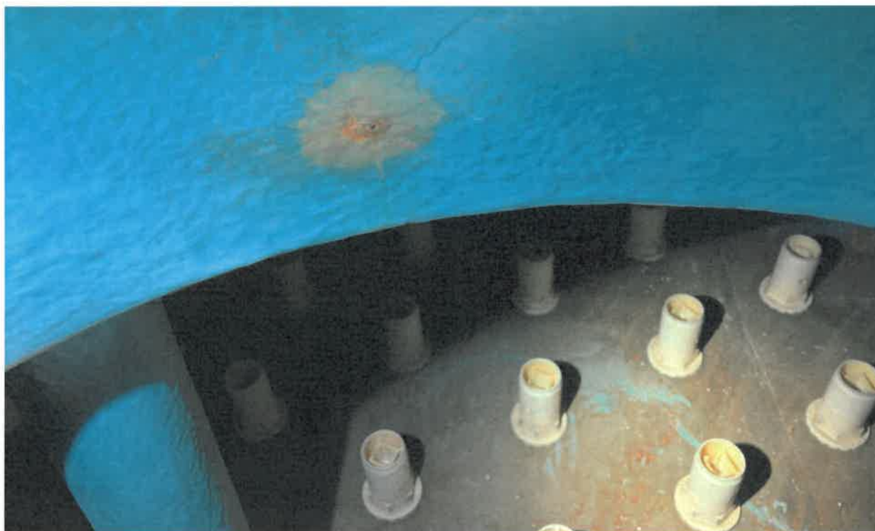
Obr. 3 – Poškození ochranného protikorozičního nátěru na vnitřní straně horního průřezu.
