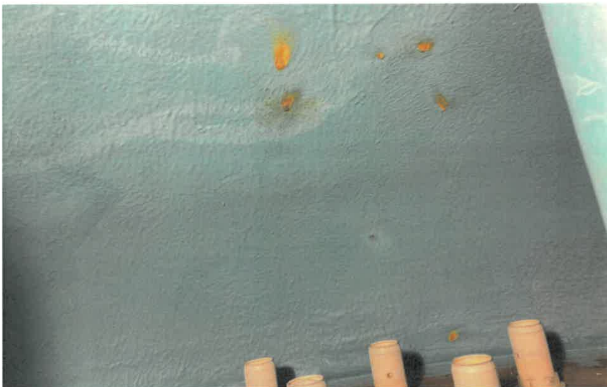
Obr. 4 – Poškození ochranného protikorozičního nátěru na vnitřní straně horního klenutého dna.
