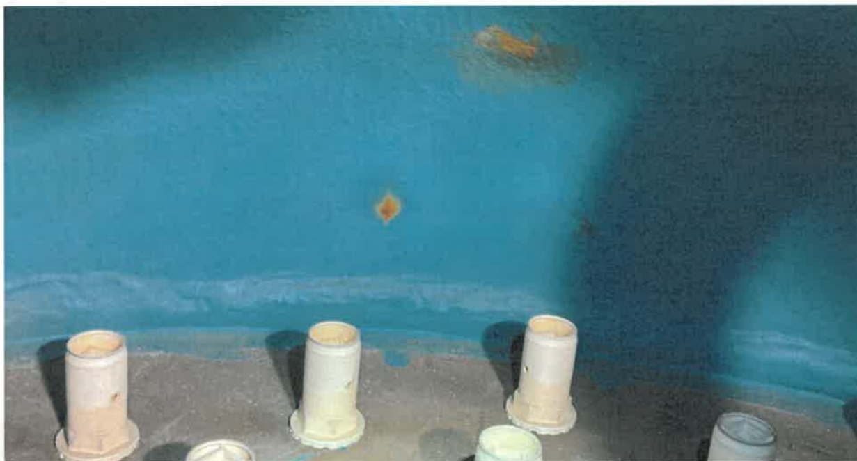
Obr. 6 – Poškození ochranného protikorozičního nátěru na vnitřní straně horního klenutého dna.
