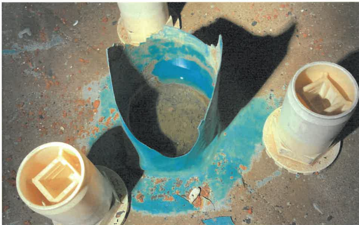
Obr. 2 – Pozůstatek ochranného protikorozičního nátěru jedné ze vzpěr.
